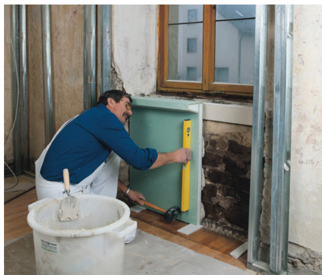
Verbundplatte aus Gipskarton und Dämmung mit Formteil zur Montage der Fensterbank
