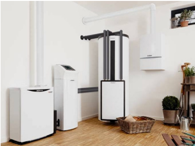
Ein Mikro-BHKW mit Pufferspeicher in einem Haushaltsraum. [Foto: Vaillant]
