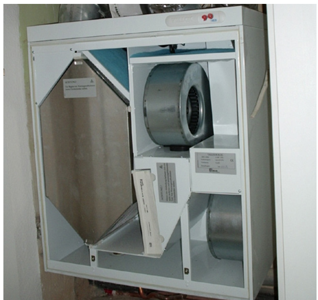
Ein Lüftungsgerät mit Wärmerückgewinnung; Abmessung ca. 80 x 80 x 50 cm
