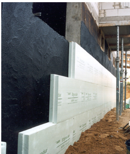
Dämmung auf der Wand eines Kellers, der zum beheizten Teil eines Gebäudes gehört.
