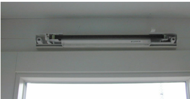
Feuchtgesteuerter Zulufteinlass über einem Fenster (Abdeckung entfernt)
