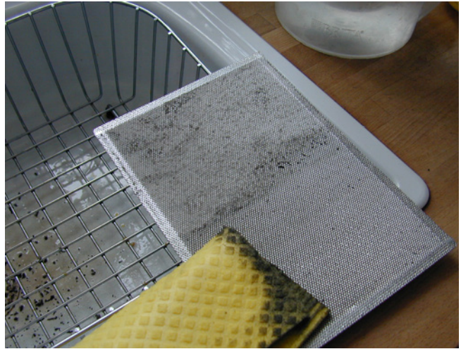
Der Filter eines Abluftventils aus Edelstahlgewebe wird mit Wasser und Spülmittel gesäubert.
