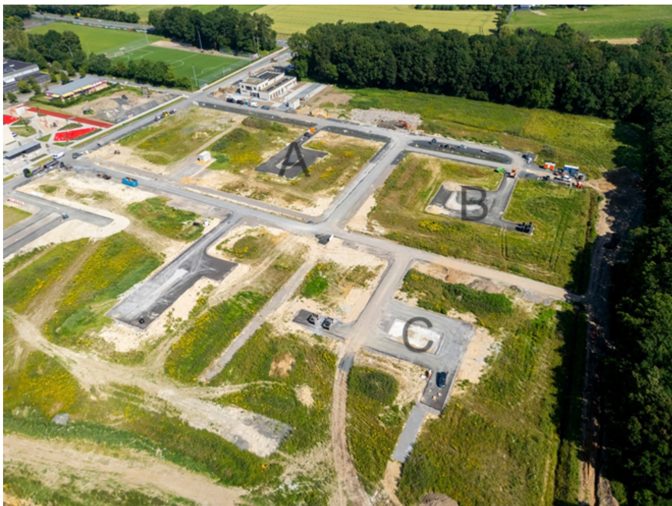
Blick aus Südosten in Richtung Weseler Straße
