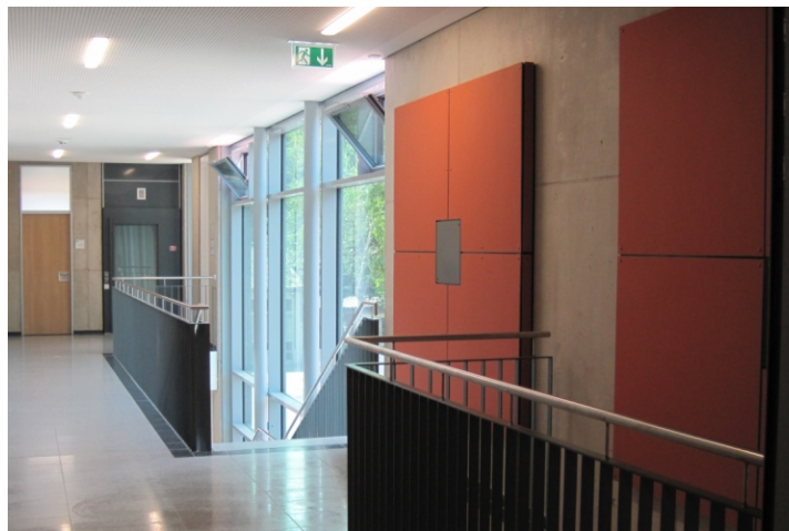
Halle im Obergeschoss
