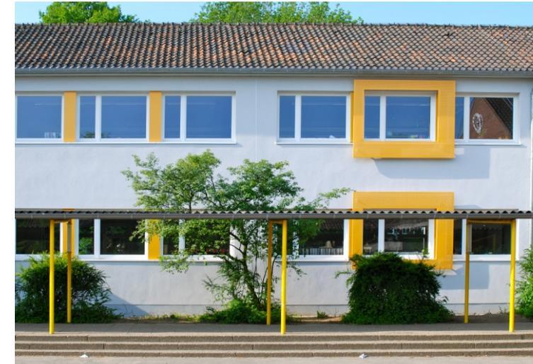
Nach Fertigstellung der ersten Sporthalle wurde dann die zweite Sporthalle, Bauteil E, saniert. Auch hier wurden die Umkleide- und Duschräume neu hergerichtet und das Dach gedämmt und neu abgeklebt. Im Februar 2010 begann die Fenstersanierung im Bauteil C. Neue Holz-Alu-Fenster mit Dreifachverglasung und neuem Sonnenschutz wurden eingebaut. Auch in den Bauteilen A und B wurden diese neuen Fenster eingebaut.
