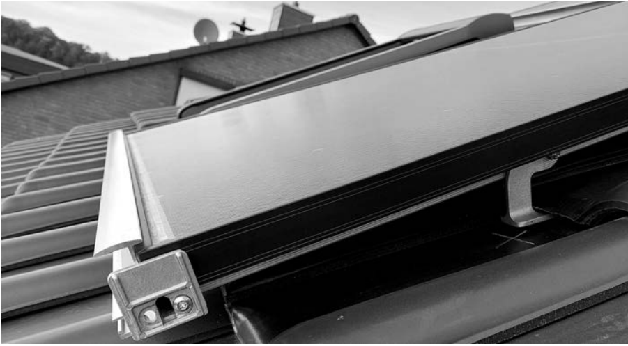
Das Gestell für die Module wird mit Haken unter die Dachpfannen geklemmt Foto: Pollerberg
