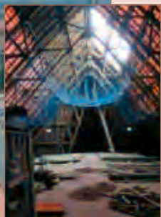
Von 2000 bis 2006/07 wurde die Lambertikirche gründlich saniert und restauriert. Allein das Dach mit seinen 1600 m 2 bekam 22.000 neue Tonpfannen in drei verschiedenen Farben, exklusiv für St. Lamberti zusammengestellt und alle zur Sturmsicherung miteinander verklammert!
