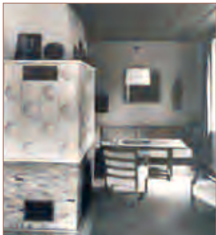
Der Innenraum aus den 1930er-Jahren ist mit der modernsten Heizung seiner Zeit versehen. Von einem zentralen Brenner wird die heiße Luft über Kanäle im Haus verteilt. Im Kachelofen wird die Wärme zusätzlich gespeichert und als Strahlungswärme wieder abgegeben.
