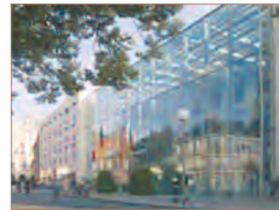
Das neue „Kleid“ der Bezirksregierung, moderne Fassadenarchitektur am Domplatz
