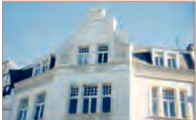
Nach einer gelungenen Gesamtrenovierung dominiert das Haus heute wieder zu Recht das Straßenbild. Dank einer alten Fotovorlage sogar mit einem – leicht vereinfachten – Schildgiebel.
