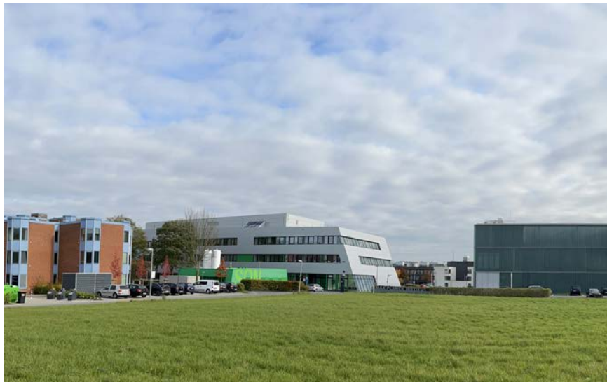
Erweiterungsflächen des Wissensquartiers (von Westen)
