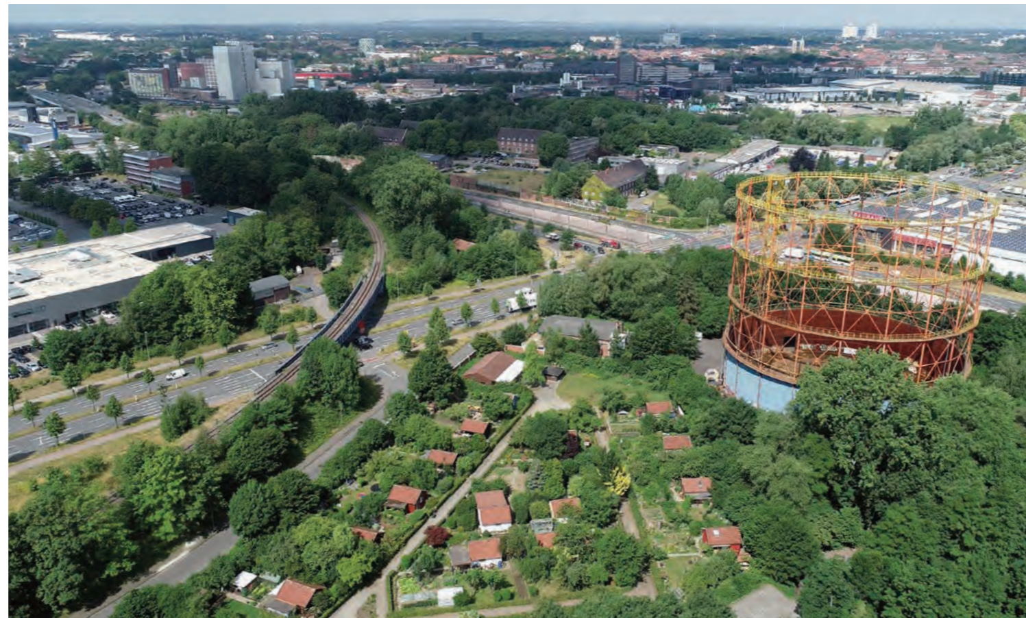
Gasometer in unmittelbarer Nähe der Quartiere
