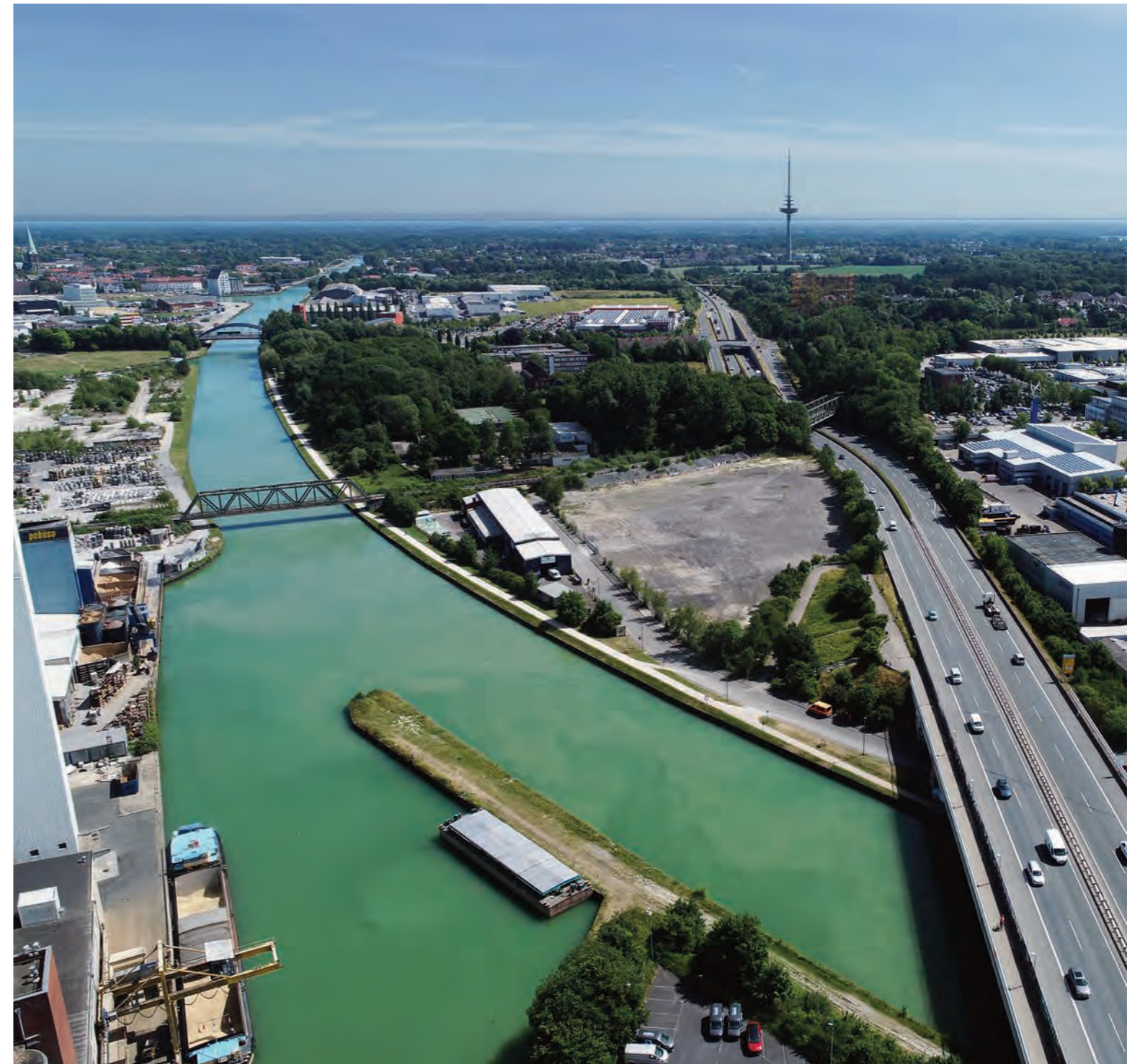
Brückenverbindungen und die Barriere der Bundesstraße
