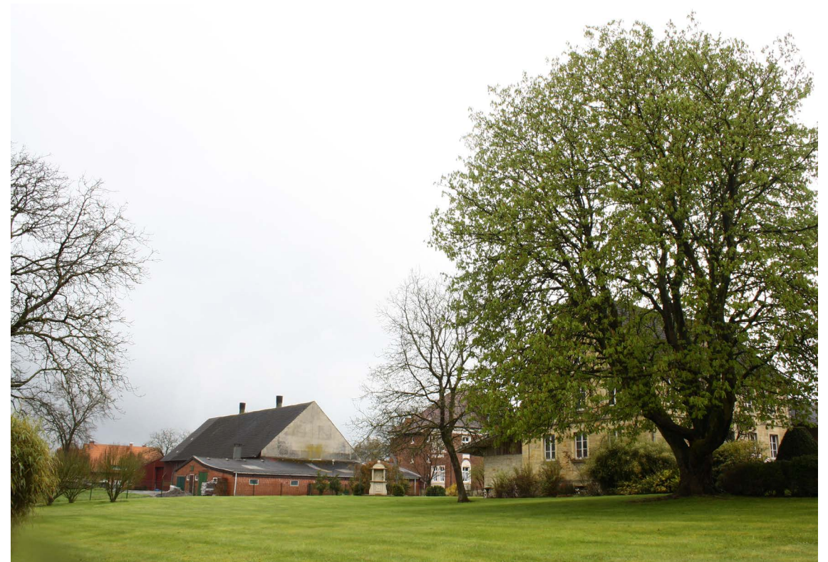
Abb.01: Zwei der denkmalgeschützten Hofanlagen, Blick von der Fuldastraße
