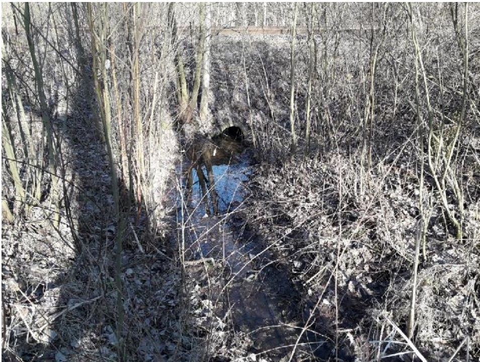
Abb.: Durchlass Entwässerungsgraben unter Bahndamm
