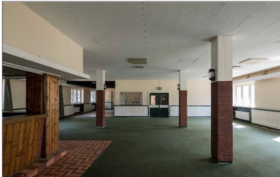
Innenansicht vor Schadstoffsanierung
