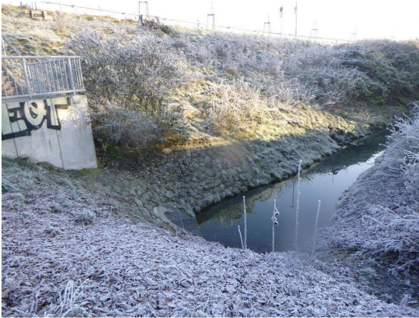
Abbildung 5: Einleitung RW-Kanal Schillerstraße in den Honebach
