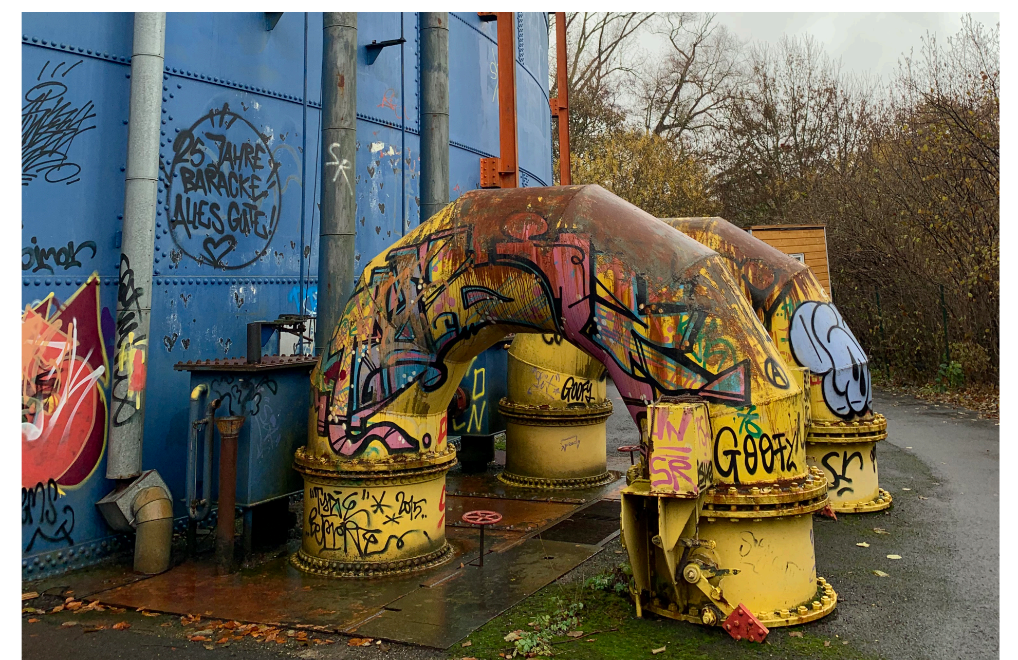
Erhaltene Gasleitungen vor dem Sperrwasserbecken Foto: ©Büro Luchterhandt
