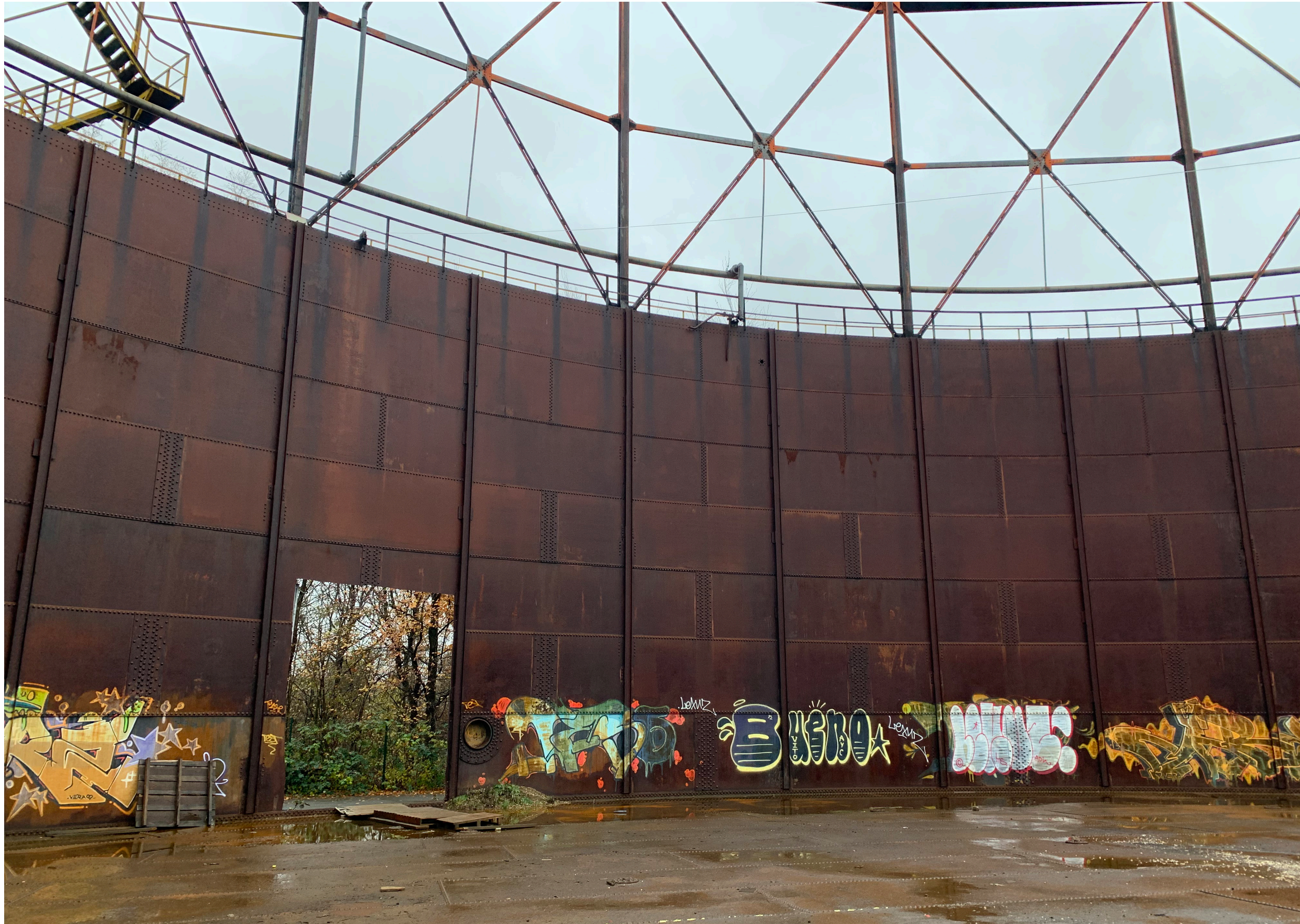
Das denkmalgeschützte Sperrwasserbecken des Gasometers heute Foto: ©Büro Luchterhandt
