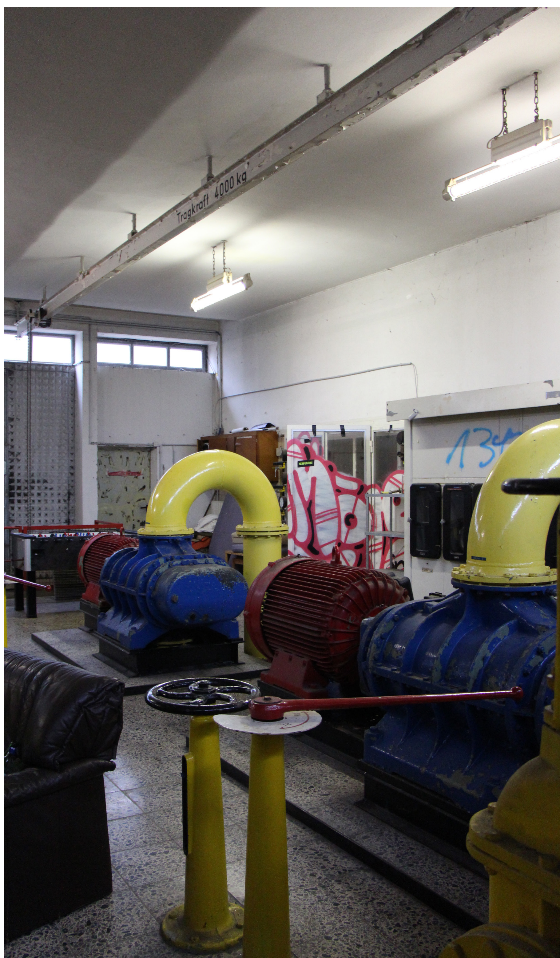
Denkmalgeschützte Verdichter mit Reglern Foto: ©Büro Luchterhandt
