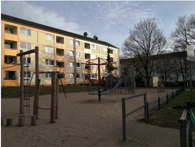
Sanierung Spielplatz Middelkamp
