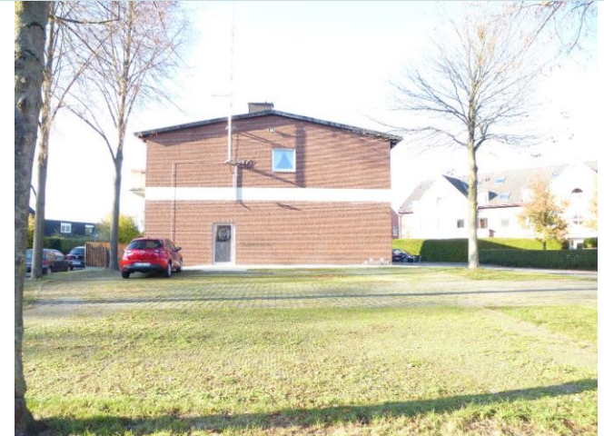
Einbau einer zusätzlichen Tür Feuerwehr Angelmodde
