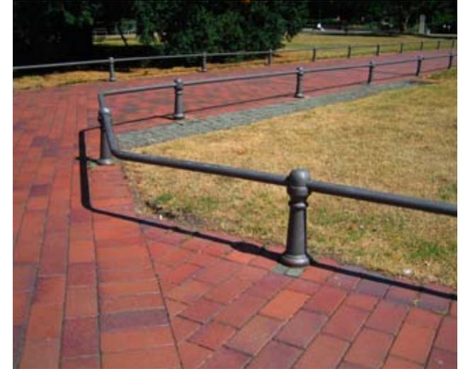
**Historischer Knieholm** (Kleimanngitter, niedrig) Graugusspfosten oder Silumin-guss, verzinkte Stahlrohre.
