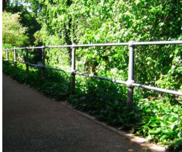
**Historischer Hüftholm** (Kleimanngitter, 2-lagig) Graugusspfosten oder Silumin-guss, verzinkte Stahlrohre.
