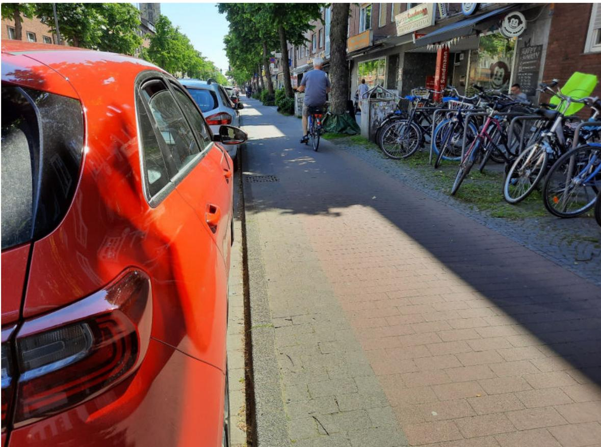
**Abbildung 6-5: Radweg mit schmalen Sicherheitsstreifen zum Parkstreifen (Hammer Str.)**
