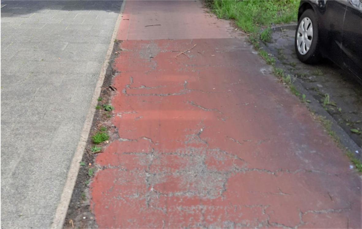
**Abbildung 6-4: Unebener Radweg mit Höhenunterschied zum Gehweg, teilweise bereits Pflasterung aufgrund beseitigter Wurzelschäden vorhanden (Dieckstr.)**
