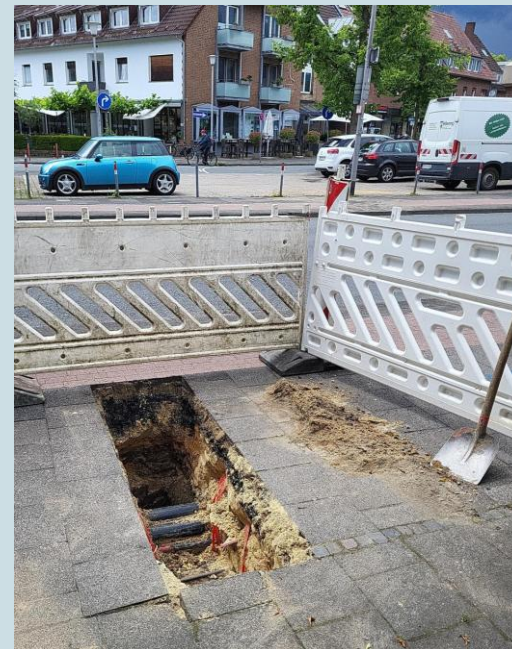
„Querschlag“ zur Überprüfung der Lage von Bestandleitungen
