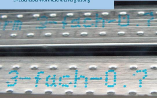
Wichtig ist auch ein dämmender sogenannter Glasabstandhalter, häufig als „warme Kante“ bezeichnet (siehe Foto). Normalerweise besteht dieser aus Edelstahl oder Aluminium, idealerweise sollte er aber aus einem anderen wärmedämmenden Material bestehen.
