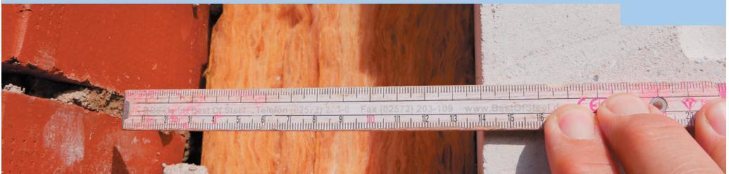
Um mit üblicher Mineralwolle einen vergleichbaren Dämmwert zu erhalten, sollten ca. 20cm Dämmstoff (abhängig vom WLS-Wert) eingebaut werden: Die technischen Mittel für eine entsprechende Mauerwerkskonstruktion (Schalenabstand von bis zu 200mm) stehen zur Verfügung, so dass ein entsprechender Wandaufbau in der Regel gut machbar ist.
