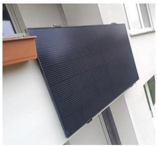
ren. Hierbei ist zu beachten, dass die Wechselrichterleistung von 600 W nicht überschritten wird. Stecker-PV-Anlagen können an vielen Orten angebracht werden. Dazu zählen die Fassade, der Garten, der Balkon oder auch das Dach.
