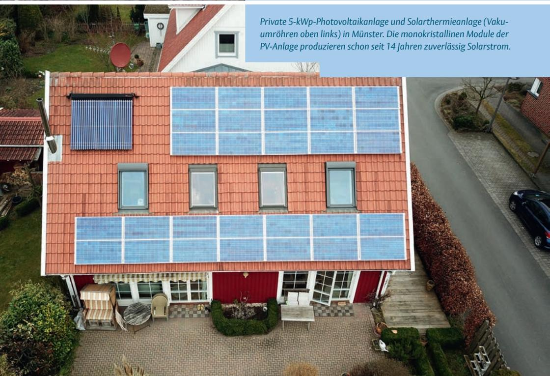
*Private 5-kWp-Photovoltaikanlage und Solarthermieanlage (Vaku-
