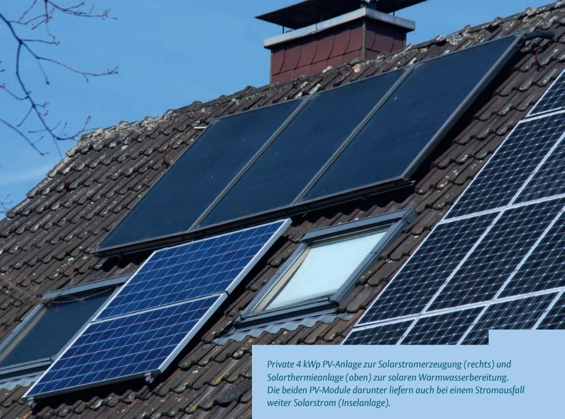
*Private 4 kWp PV-Anlage zur Solarstromerzeugung (rechts) und Solarthermieanlage (oben) zur solaren Warmwasserbereitung. Die beiden PV-Module darunter liefern auch bei einem Stromausfall weiter Solarstrom (Inselanlage).*
