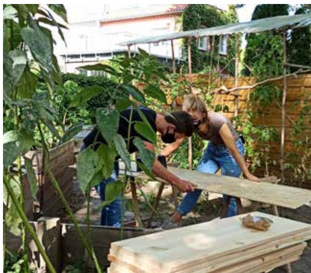
Der gemeinsame Bau von Hochbeeten
