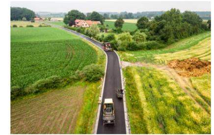
Einbau von Asphalt mit erhöhtem Recyclinganteil
