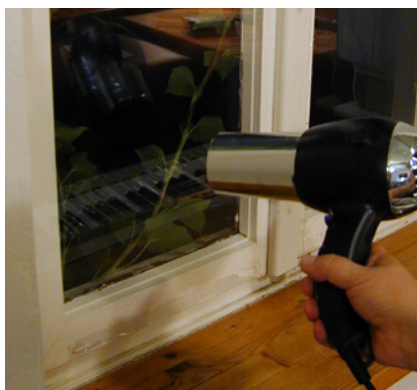
Fensterfolien über den Rahmen ziehen und anschließend mit einem Föhn erwärmen. So verschwinden alle Falten.
