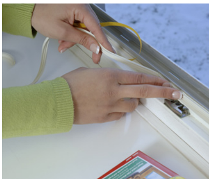
Richtiges Anbringen der Dichtungsbänder
