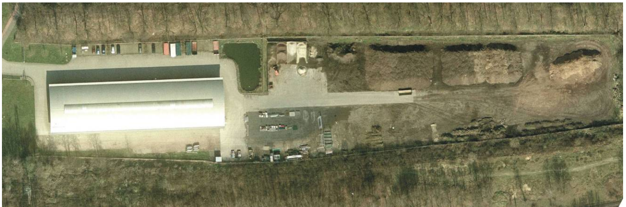
Abb.: Luftbild vom Betriebshof Höltenweg
