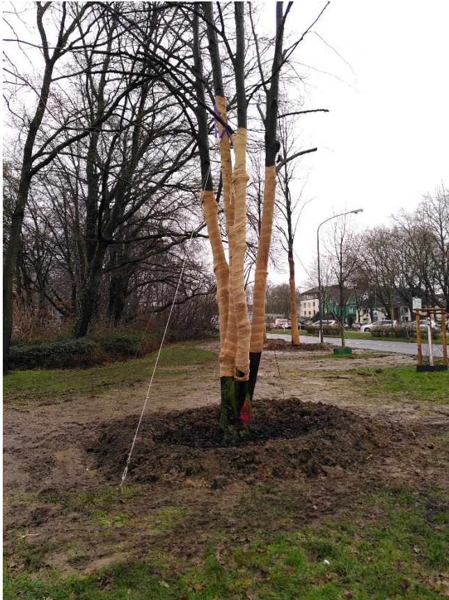
Abbildung 7: Sicherung von verpflanzten Bäumen mit Stahlseilen (ähnlich vorbereitende Maßnahme)
