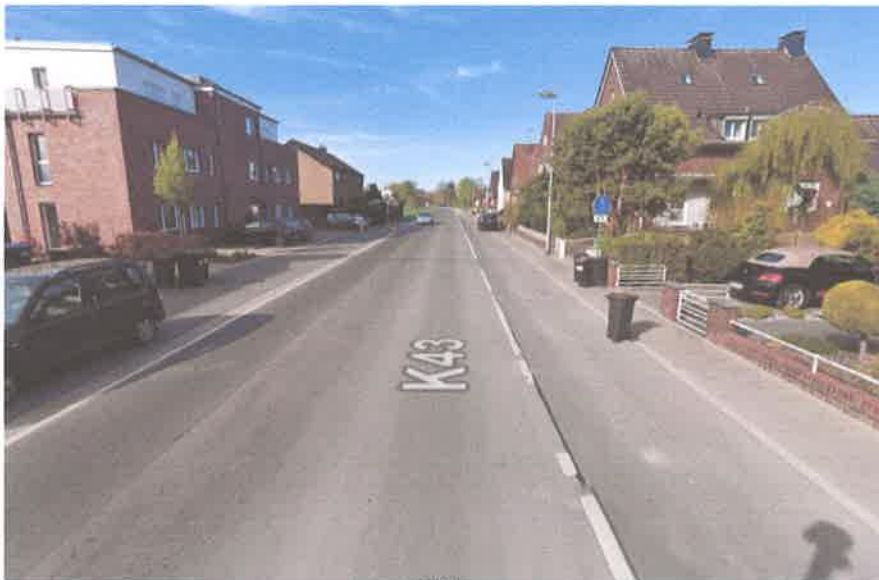
Abbildung: Die teilweise fehlende Fahrbahnseitenmarkierung ist großräumig die einzige Abgrenzung zwischen Geh-/Radweg und Fahrbahn der Mariendorfer Straße.
